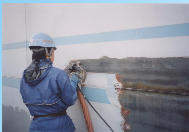
塗膜除去状況
