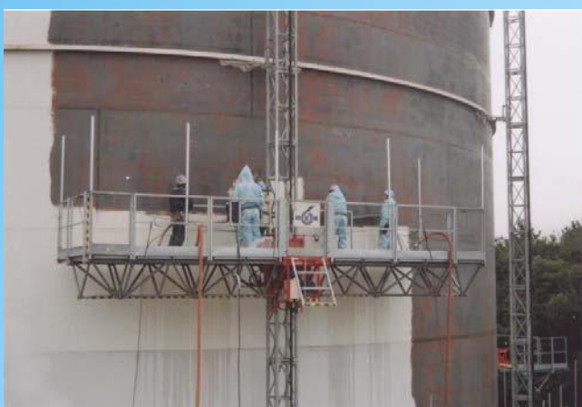
移動式可動足場 (多機能ワークプラットフォーム) による足場作業
