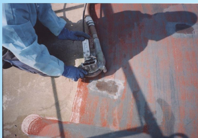
塗膜除去状況
