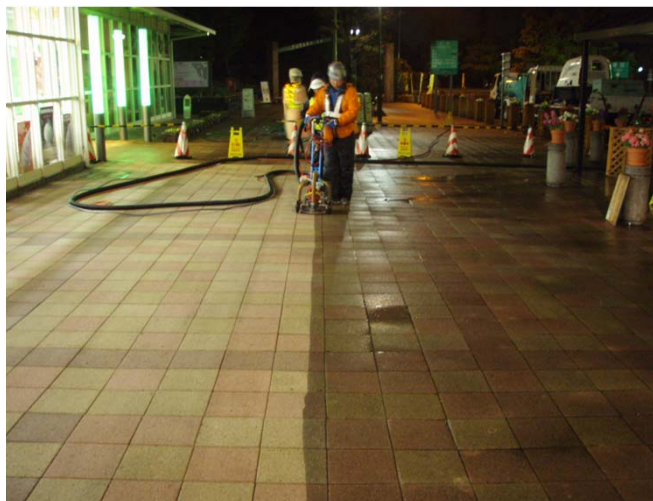
《敷石洗浄工事》
