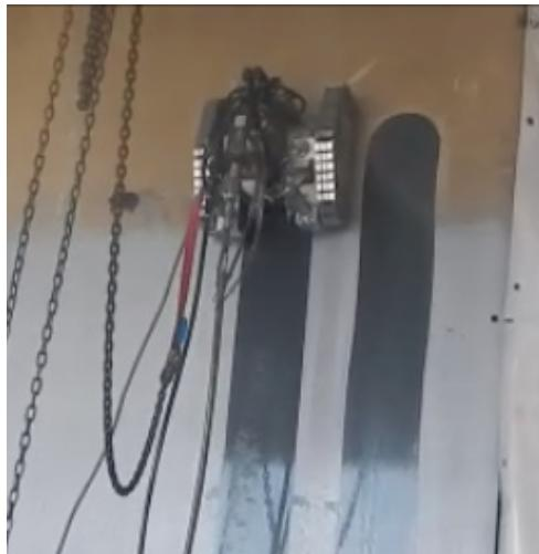
人力での施工が困難な垂直、オーバーハング壁も遠隔操作で安全に施工を行うことができます。
