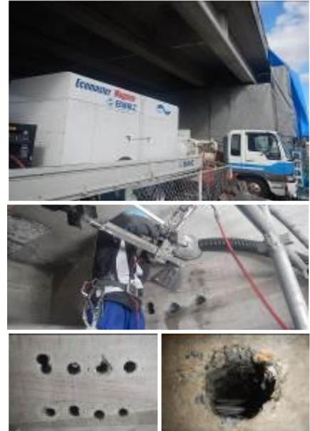
■ PC 桁などの WJ 削孔用ツールとして開発、新工法として導入。
