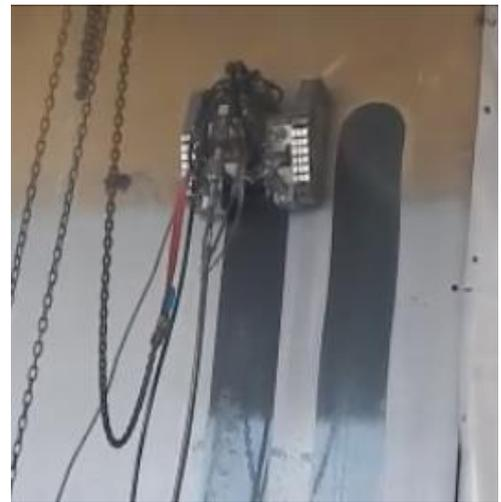
人力での施工が困難な垂直、オーバーハング壁も遠隔操作で安全に施工を行うことができます。
